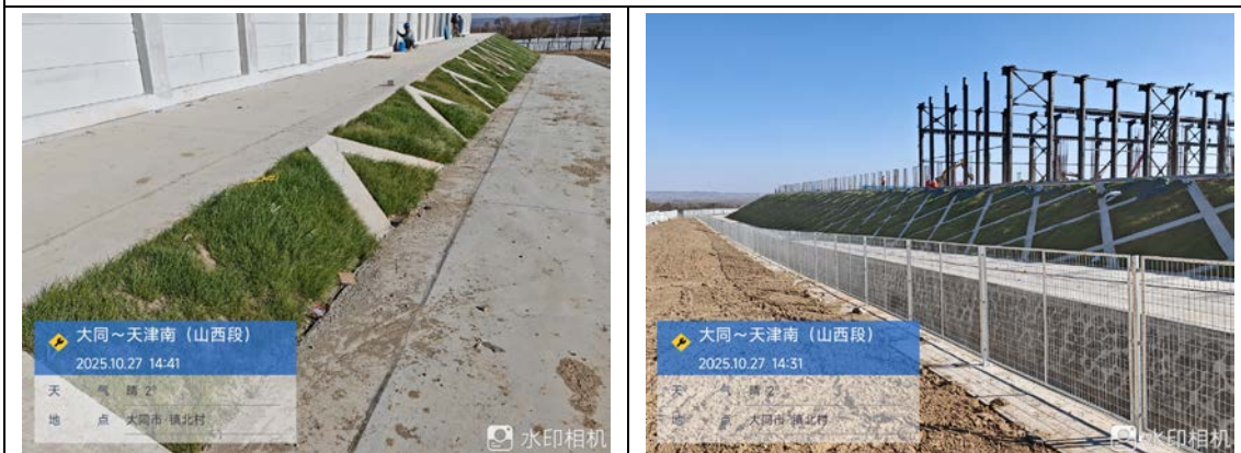
大同变电站站区框格植草护坡
